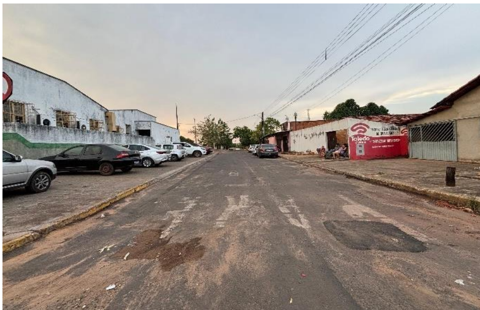
Figura 23. Rua dos Bacuris, vista panorâmica. Imagem registrada em: 17 ago. 2024.
