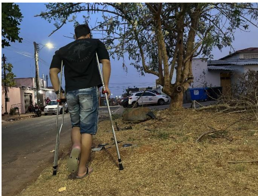
Figura 29. Trecho sem a presença de calçada com acessibilidade. Imagem registrada em: 28 set. 2024.
