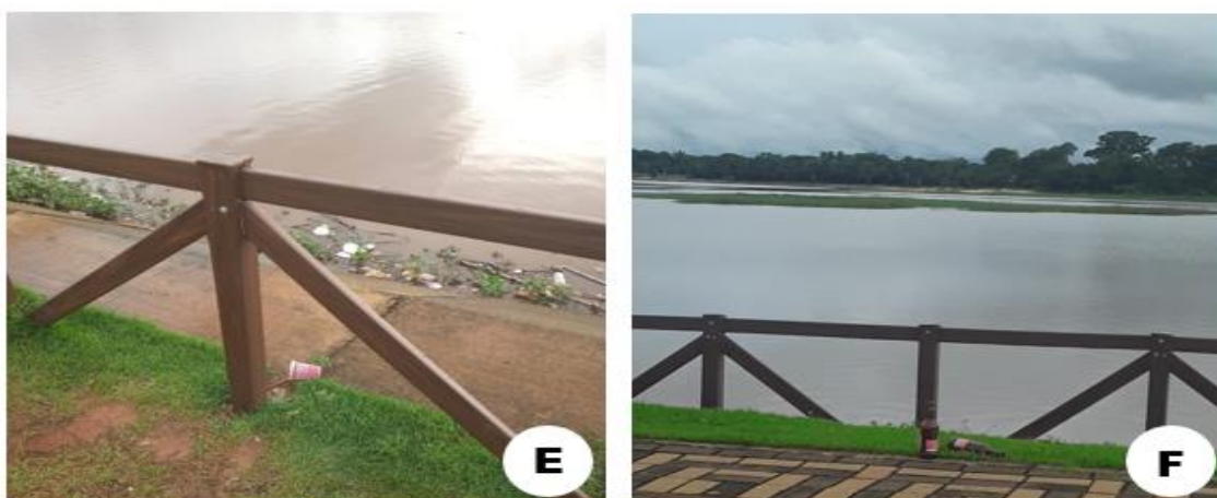
Figura 4. Cerca de Proteção da Via Lago (E); Extensão da Via Lago (F)
