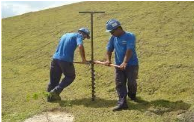
Figura 01: Sondagem a Trado.
