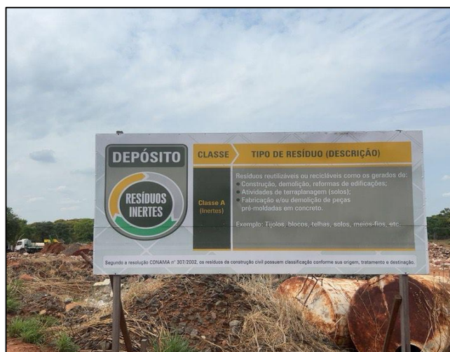
Figura 4: Aterro de Inertes em Araguaína – TO.
