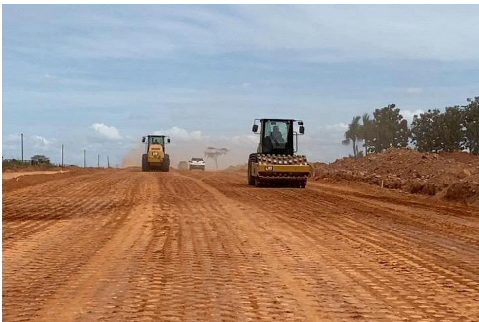
Figura 7: Preparação do subleito para recebimento do pavimento asfáltico.
