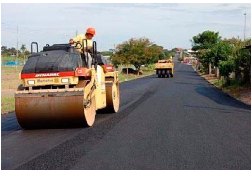
Figura 10: Compactação da pista com o rolo compresso.
