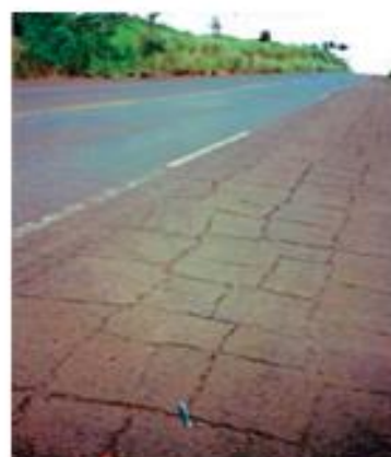
(f) Trincas de bloco sem erosão (TB)
