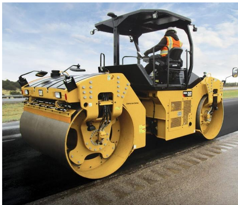
Figura 6: Rolo compressor utilizado na compressão da mistura asfáltica na pista.
