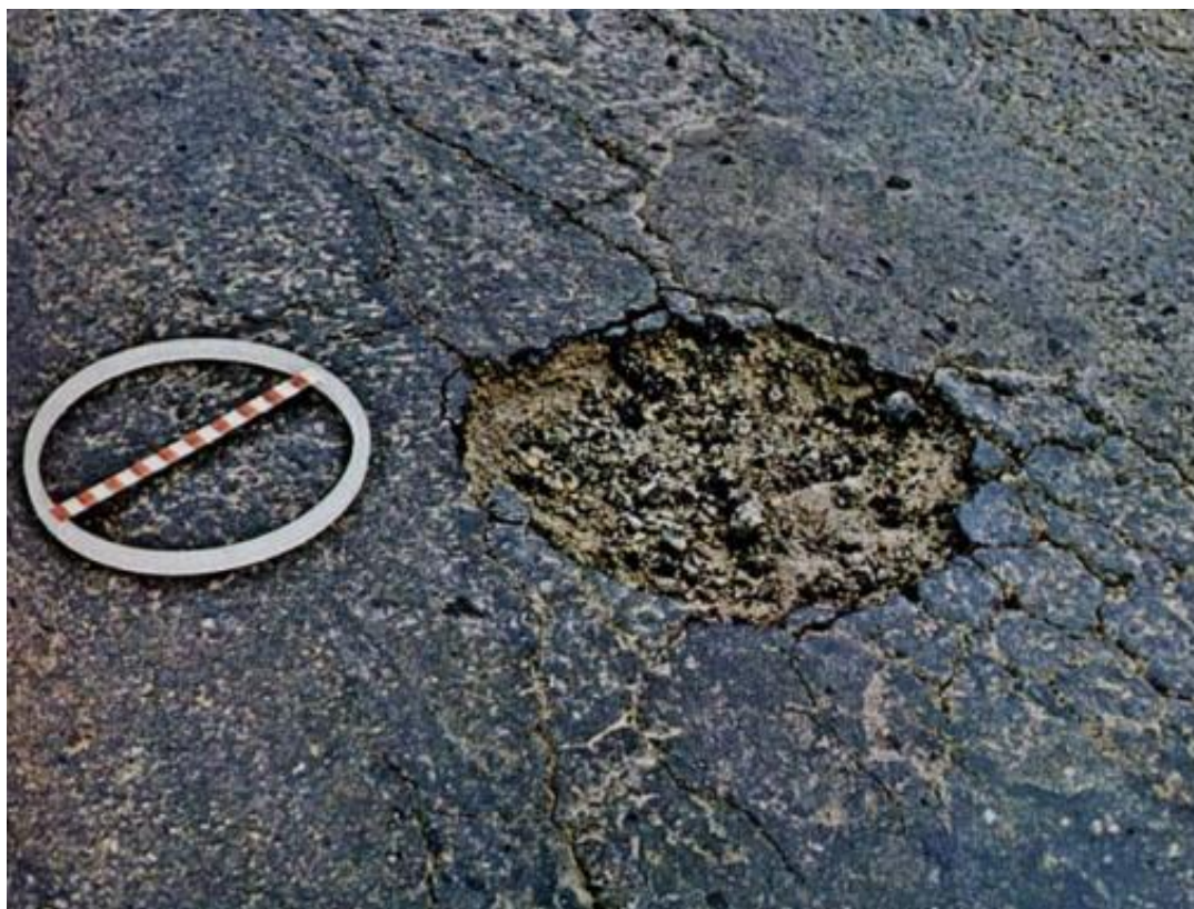
Figura 21: Buraco na pavimentação asfáltica.
