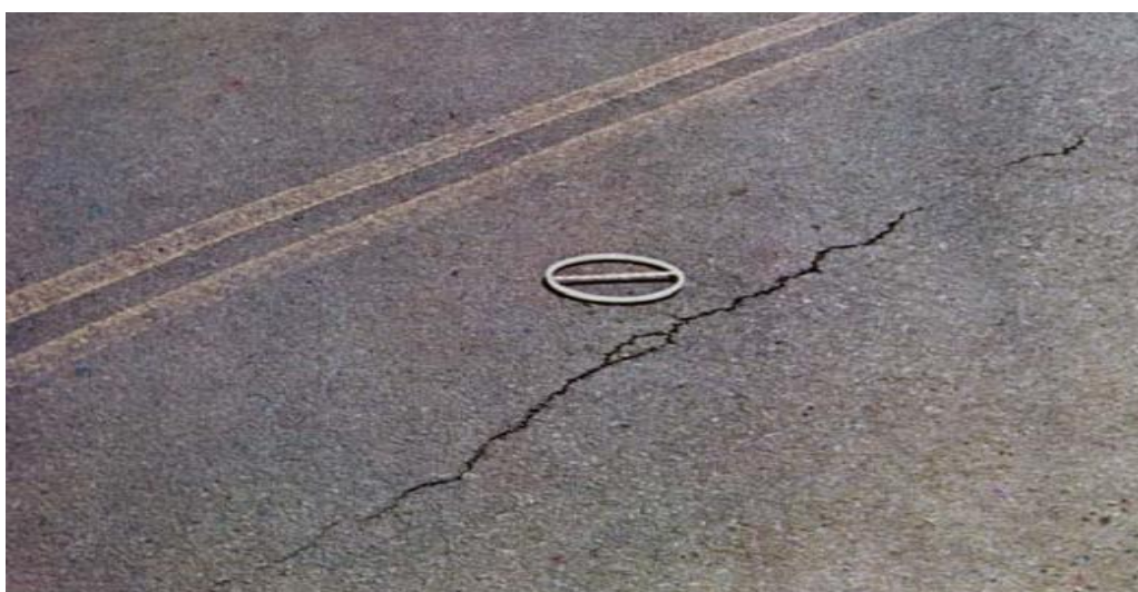
Figura 13: Trinca isolada longitudinal em pavimentação asfáltica.
