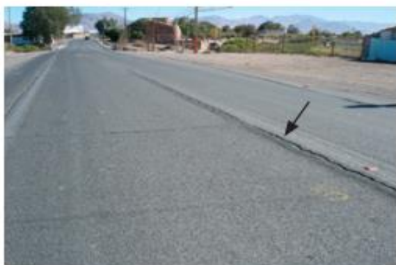
(c) Trinca de retração (TRR)
