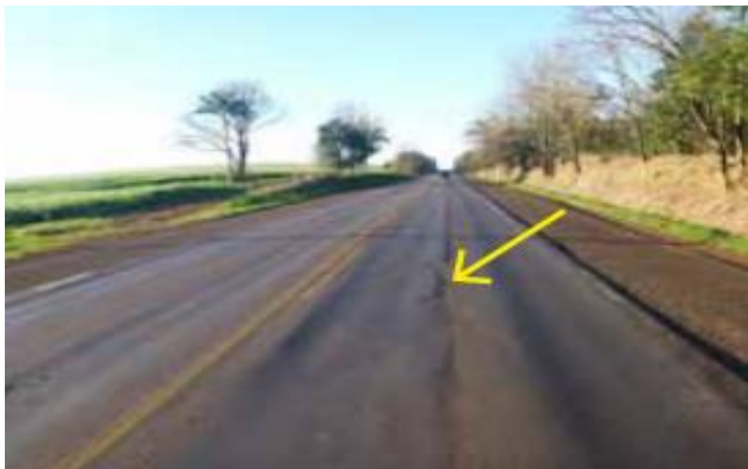
Figura 17: Afundamento plástico nas trilhas de roda.
