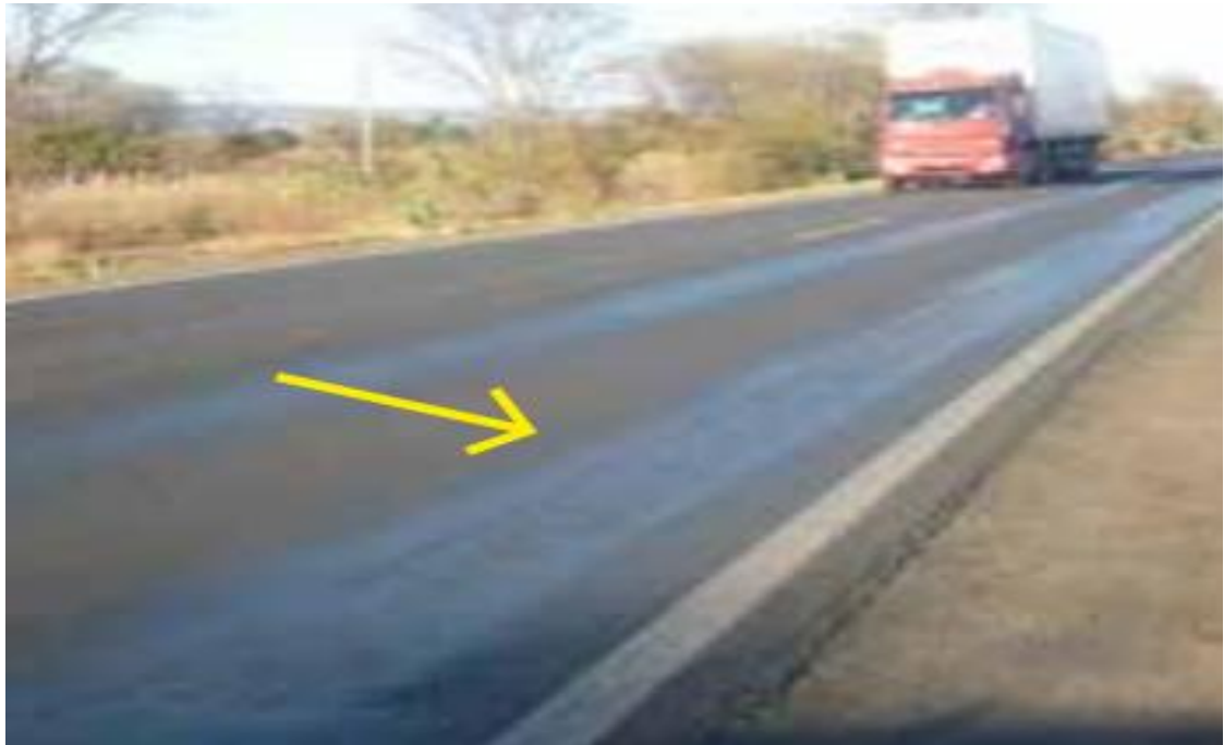
Figura 20: Exsudação na pavimentação asfáltica.
