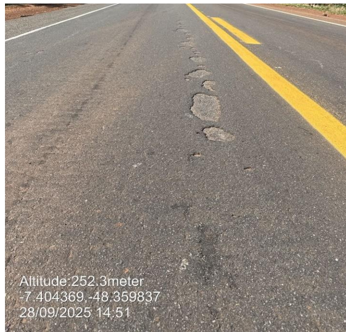
Figura 30: Buraco com degradação rasa.
