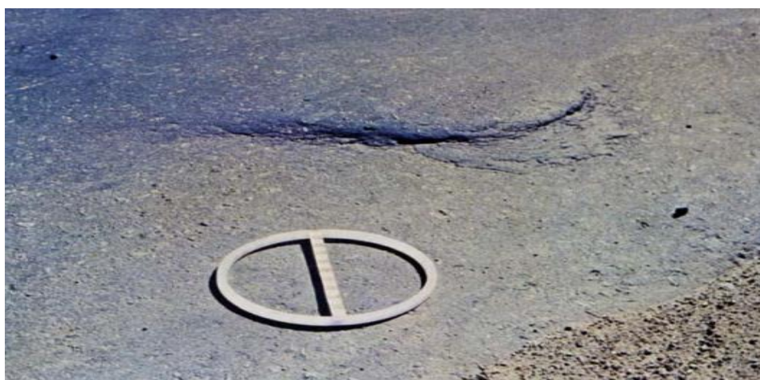
Figura 19: Escorregamento na pavimentação.
