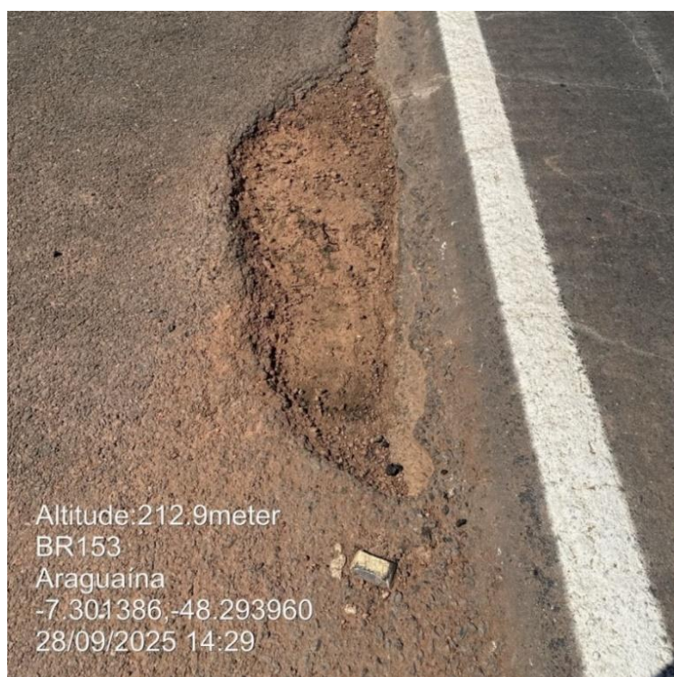
Figura 28: Buraco com degradação profunda.
