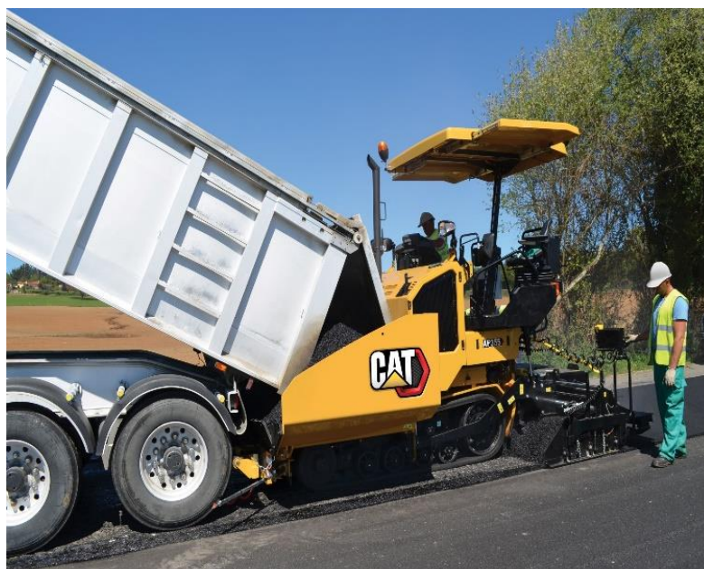
Figura 5: Máquina pavimentadora automotriz utilizada na distribuição da mistura asfáltica na pista.
