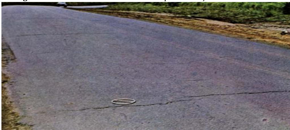
Figura 12: Trinca isolada transversal em pavimentação asfáltica.
