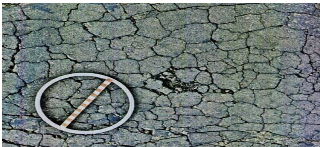
Figura 15: Trinca tipo “Couro de Jacaré” em pavimentação asfáltica.
