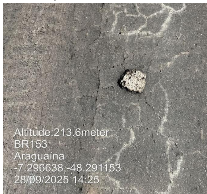
Figura 31: Buraco formado em área com concentração de trincas.
