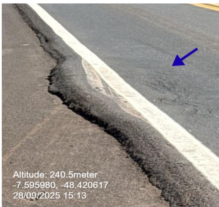
Figura 32: Afundamento.
