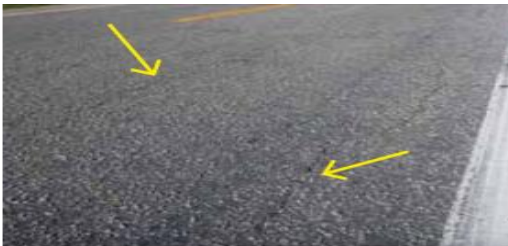
Figura 11: Fissura em pavimentação asfáltica.
