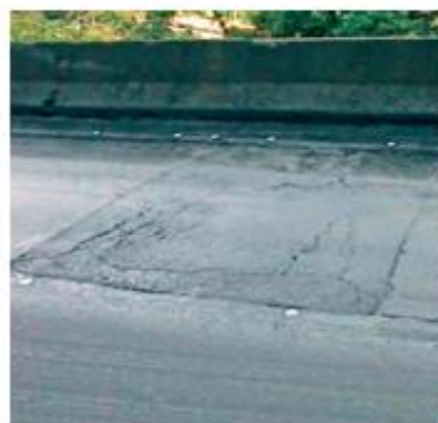
(d) Trinca de retração (TRR)
