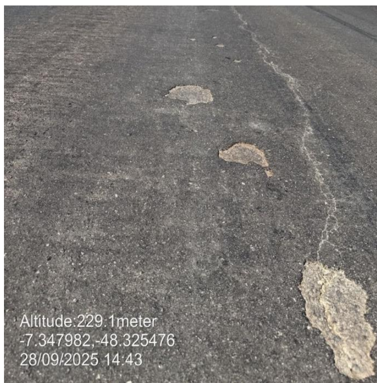
Figura 29: Buraco com degradação rasa.
