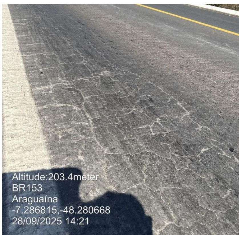
Figura 24: Trinca tipo “couro de jacaré”.
