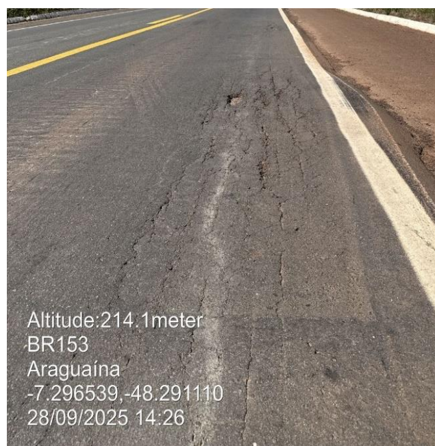
Figura 26: Trinca longitudinal longa.
