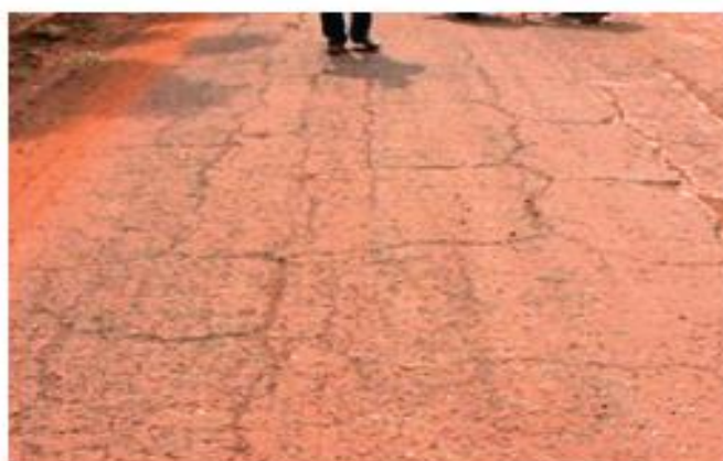
(e) Trincas de bloco com erosão (TBE)
