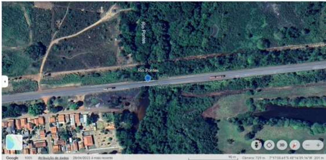
Figura 8: Posição geográfica da ponte analisada.
