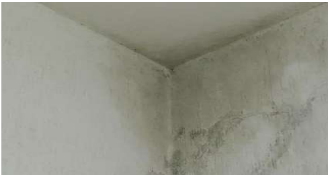
Figura 4: Infiltração.
