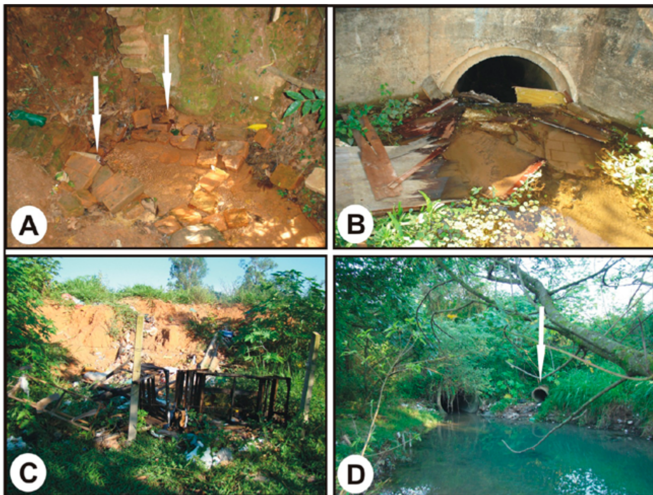
Figura 2. A. Nascente do córrego Jardim Bandeirante com dois olhos d'água (setas). B. Primeira manilha após a nascente que conduz a água do córrego. C. Bota-fora no estradão. D. Manilha de esgoto e/ou água pluvial após o estradão (seta).
